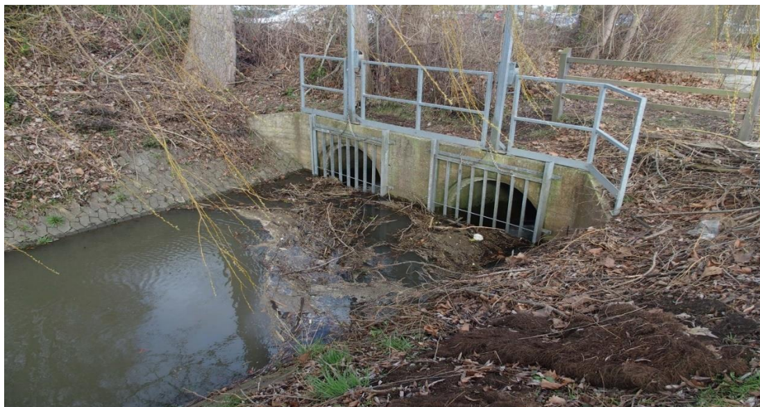
Figur 2-2 Solrød Bæk kan, grundet befæstelse og rørlægning, ikke forventes at opnå målopfyldelse.
