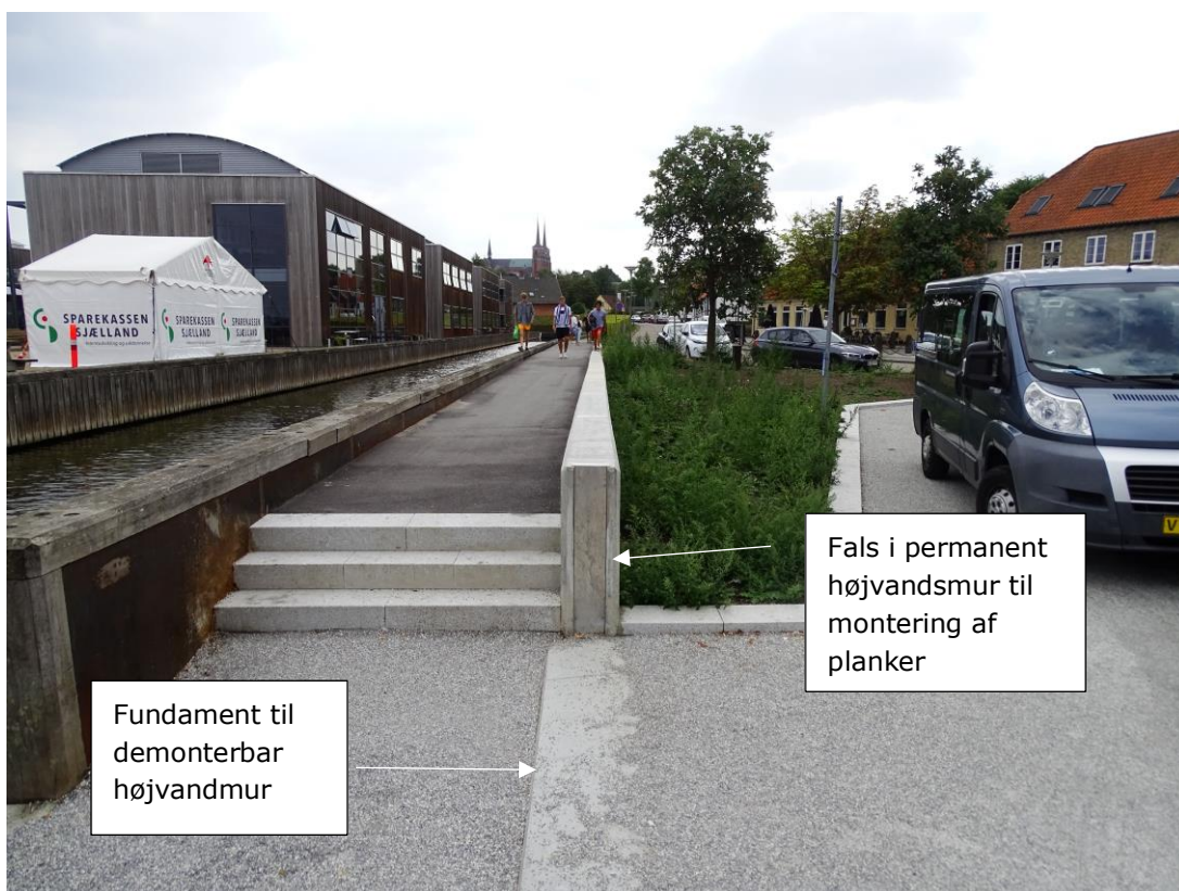
Figur 2-15: Eksempel på overgang mellem fast højvandsmur og demonterbar mur fra Roskilde Inderfjord
