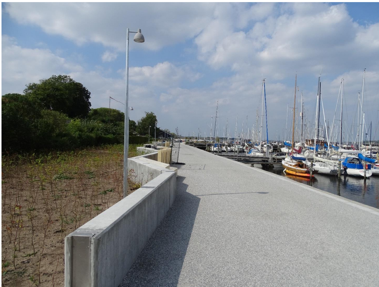
Figur 2-19: Højvandsmur i beton, eksempel fra Roskilde
