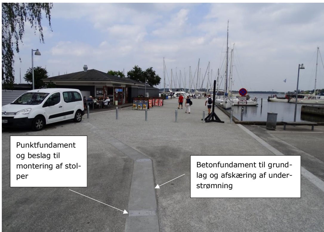
Figur 2-14: Eksempel på synlig del af fundament til demonterbar højvandsmur fra Roskilde Inderfjord
